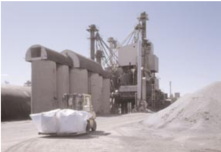
BEI facility in Waterdown, Ontario.
