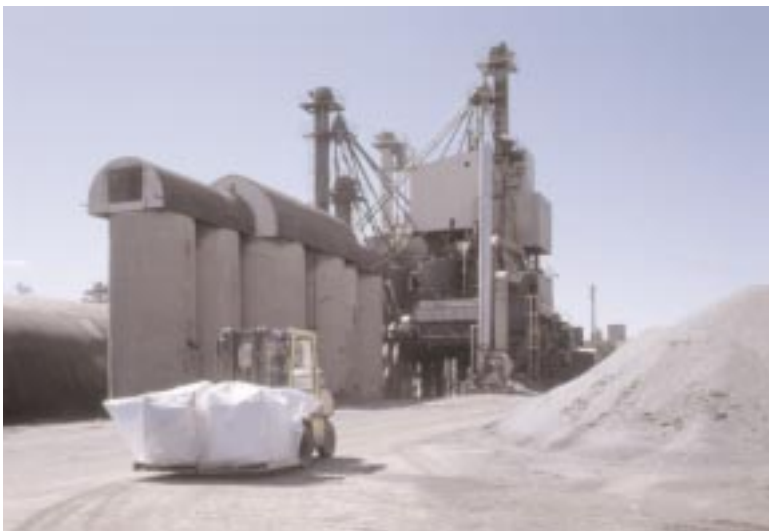
BEI facility in Waterdown, Ontario.
